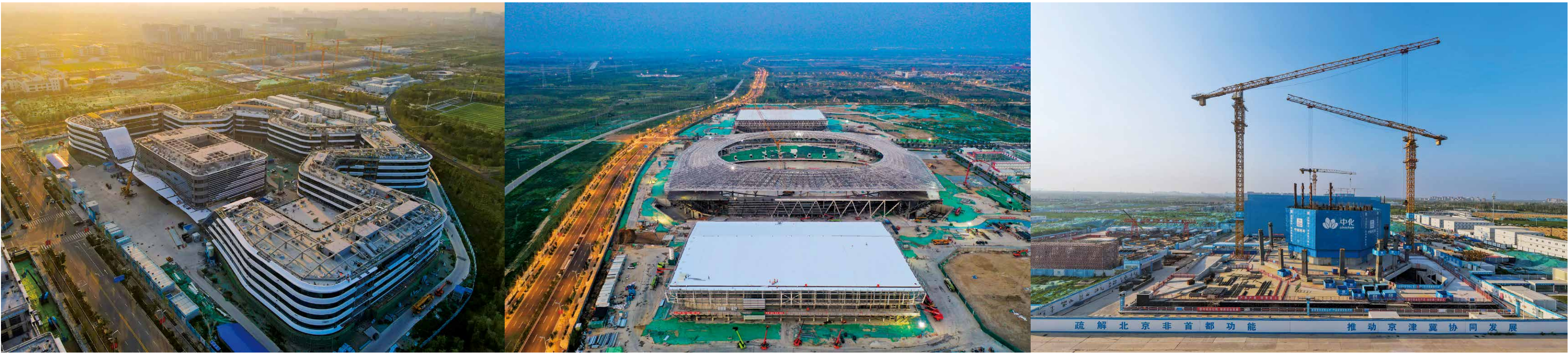
雄安新区启动区作为疏解北京非首都功能的首要承载地，各重点项目建设正有力有序推进。目前，中国星网总部主体完工；中国华能总部加快建设；雄安体育中心项目体育馆、游泳馆屋顶钢结构等均已施工完成。
