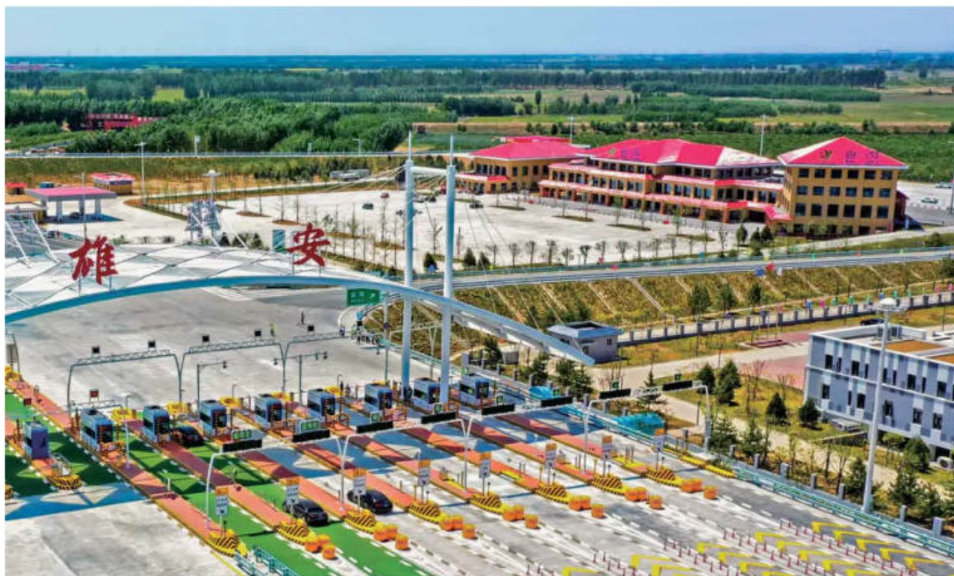
2023年12月28日京雄高速公路全线通车，由北京西南五环驾车至雄安新区实现1小时通达。图为京雄高速公路雄安收费站
